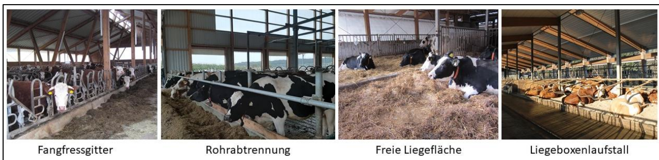
Abbildung 25: Beispiele für Abtrennungen im Fressbereich und der Gestaltung des Liegebereichs (Bildquellen von links nach rechts: Benz, LAZBW, Benz, Plesch).
